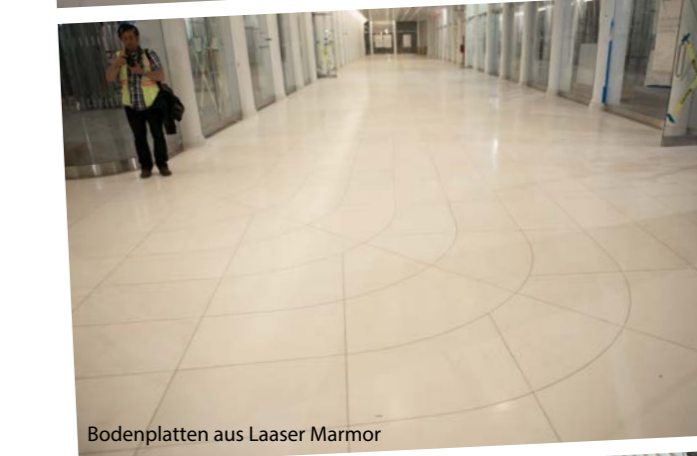
Verlegung der Bodenplatten
